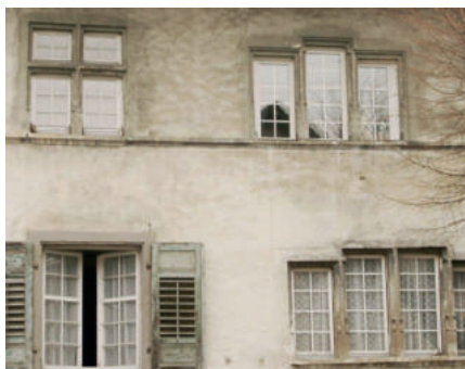
Fassade vor der Renovation
