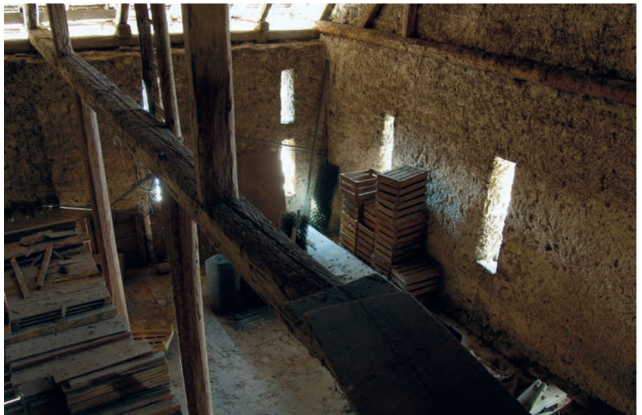
Luftschlitze in den Wänden der Scheune sind Zeitzeugen der bäuerlichen Vergangenheit.
