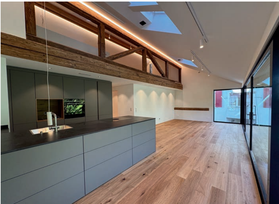
Die Erhöhung der Traufe und der Einsatz von Altholz ermöglichen hochwertigen Wohnraum.
