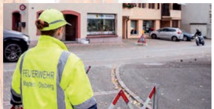
Eigene Sicherheit geht vor: Die Verkehrsabteilung stellt sicher, dass keine Unbefugten den Schadenplatz passieren und somit die Sicherheit der Arbeitenden gewährleistet ist.
