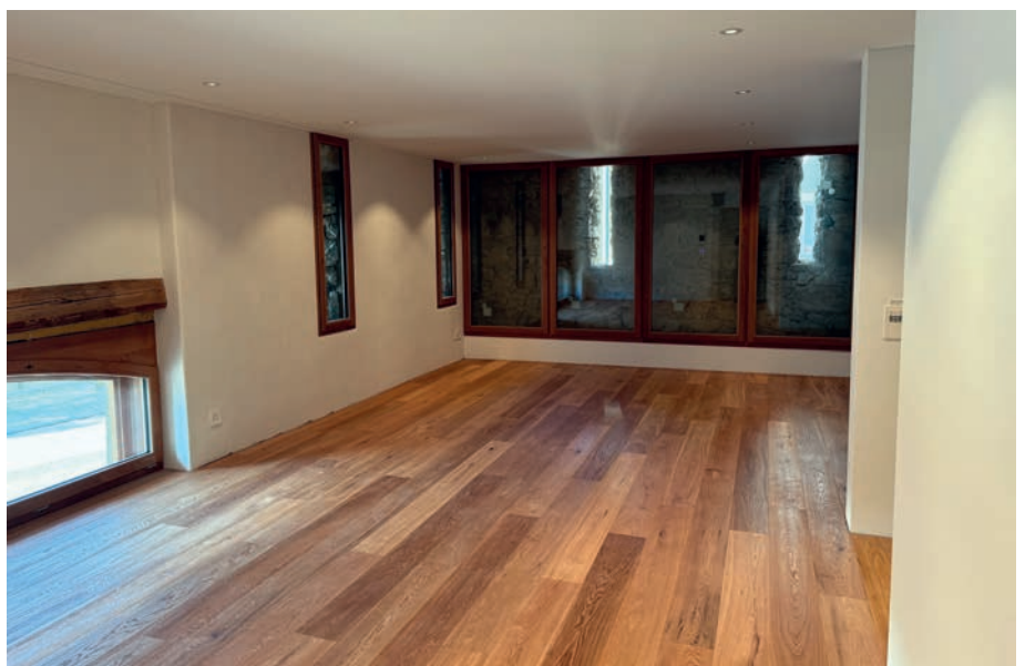
Die Luftschlitze sind erhalten, jetzt aber verglast. Links das halbrunde Fenster unter dem Jochbogen des Tenntores
