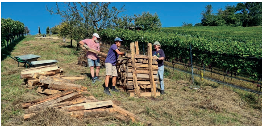
Freiwillige von BirdLife Zürich helfen Markus Stalder beim Bau der Holzbeige.
