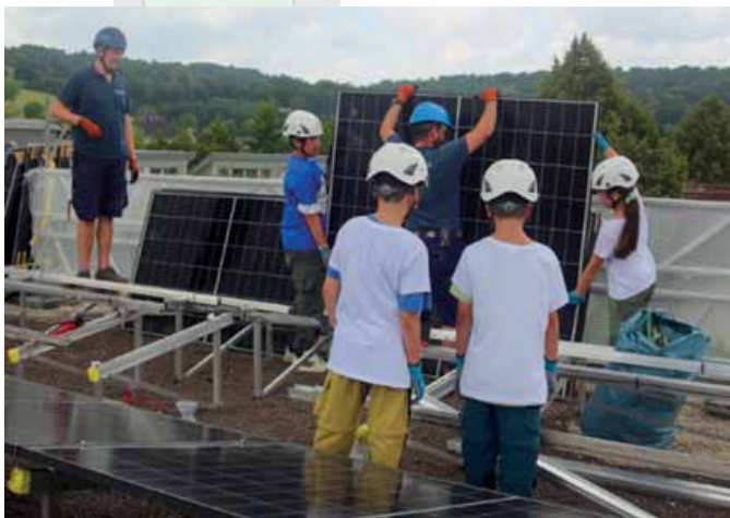
Impact Day Solarenergie: Schüler der Primarschule Magden helfen unter fachkundiger Anleitung beim Bau der Solaranlage mit.
