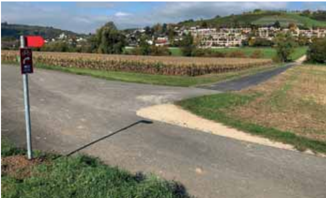
Radweg Salzackerweg – Brücke
