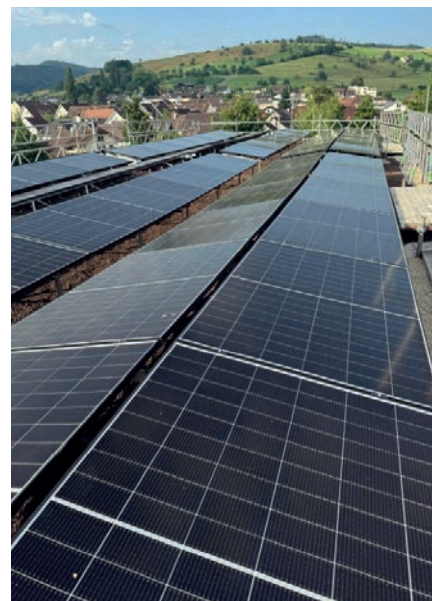
Dachsanierung des Schulhauses 1994 mit neuer Photovoltaikanlage
