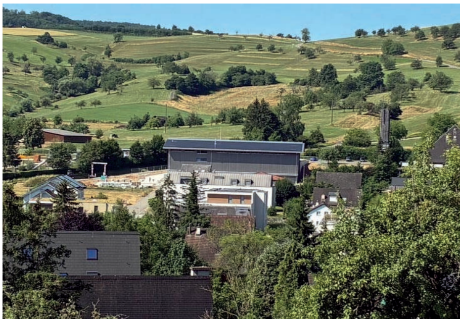
Neuer Werkhof mit Photovoltaikanlage
