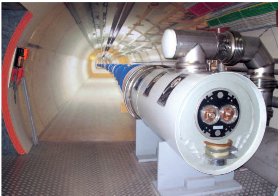
Teil des kreisförmigen, unterirdischen Ringes
