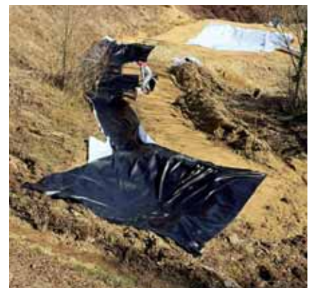
Ausgelegte Folien und Schutzvliese
