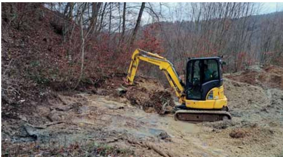
Mit dem Bagger wird die Planie erstellt
