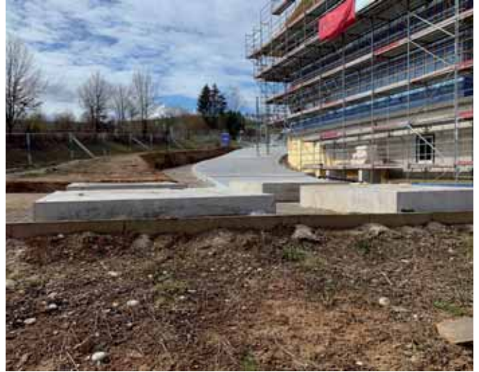
Nach der Entfernung der Kranfundamente wird hier die neue Unterflursammelstelle erstellt.
